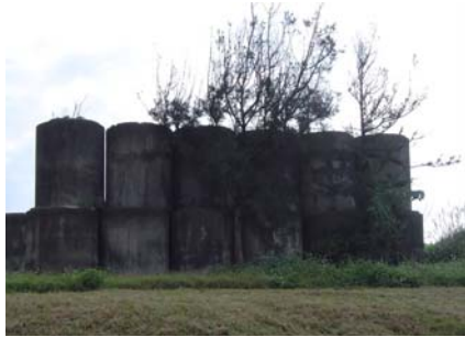
圖3. 水泥柱擋牆。
